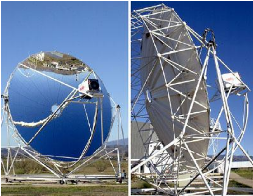
Almeriako planta solarrean kokatutako EURODISH disko parabolikoak. Stirling erako motoreak erabiltzen dira bero energia, energia elektrikoan bihurtzeko.
